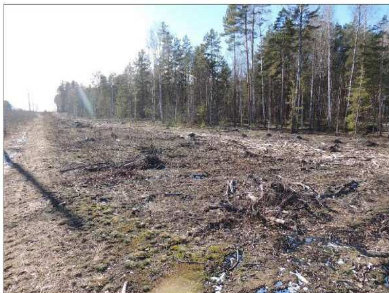
Рисунок 3.13 – Вырубка сосняка мшистого в переделах расширения ЛЭП
