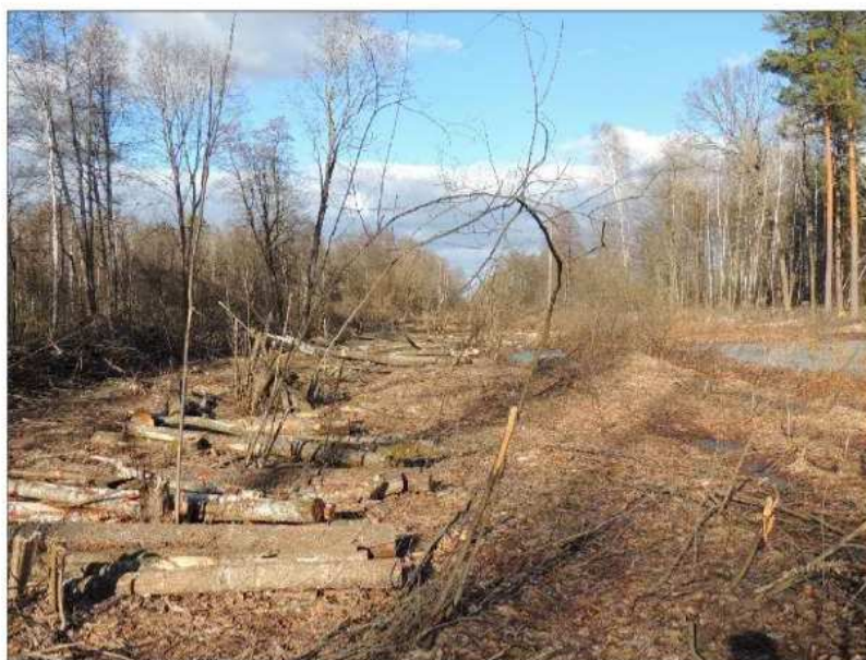
Рисунок 3.17 – Сплошная рубка в зоне расширения ЛЭП
