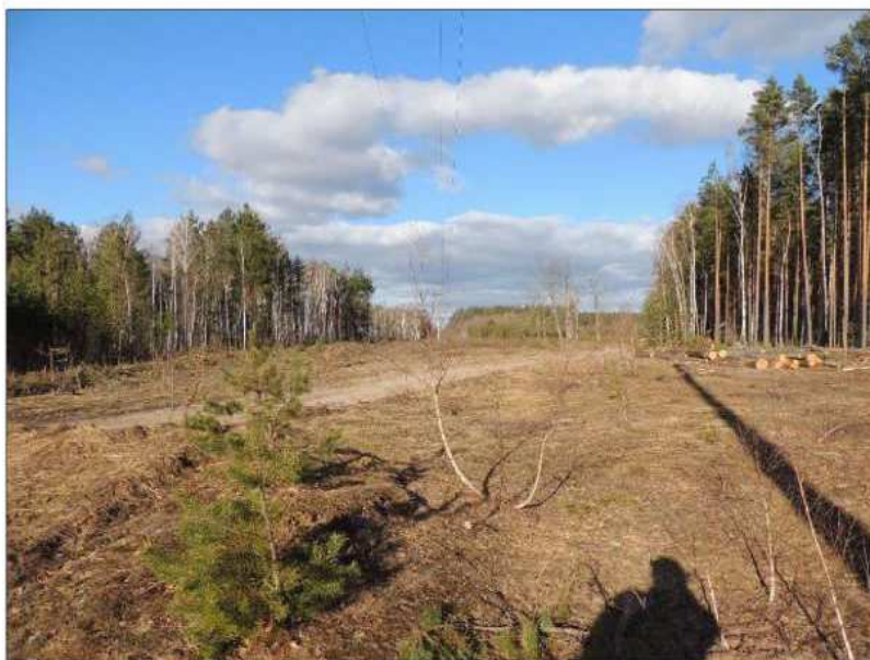
Рисунок 3.18 – Сплошная рубка в зоне расширения ЛЭП
