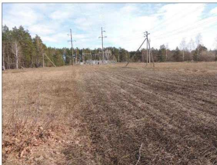
Рисунок 3.5 – Ксерофитная растительность на песчаных почвах в местах прохождения ЛЭП
